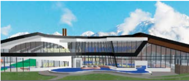
Ansicht von Süden mit der Erweiterung des Kinderbereiches (li.) und Ruheraum mit Sonnenterrasse im Obergeschoss
